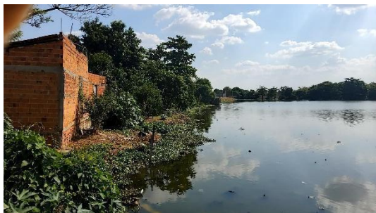
Figura 12 – Ocupação marginal à lagoa exposta aos processos de inundação e erosão da margem de aterro promovida pela dinâmica hídrica (Setor PI_TERESIN_SR_073_SGB).
