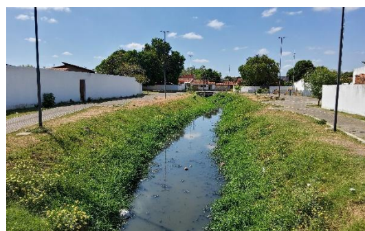
Figura 17 – Exemplo de dispositivo (canal) de drenagem interligando as lagoas e sistemas de drenagem urbanos.
