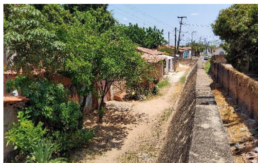
Figura 07 – Moradias instaladas entre o dique de contenção e o leito do Rio Poti (Setor PI_TERESIN_SR_138_SGB).
